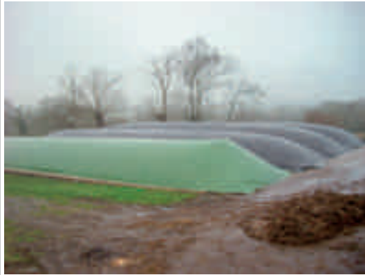
ARIA ENERGIES (1 er modèle, France) Expérience depuis 5 années - 4-5 installations
